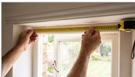
Il nastro appoggiato da muro a muro in alto: così si misura L1
