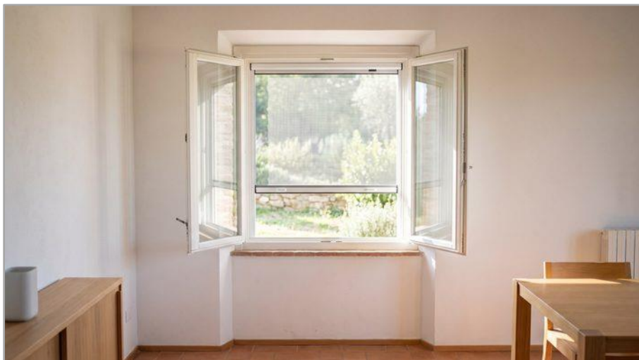
Zanzariera a rullo verticale montata nel vano finestra: il cassonetto in alto, le guide sui lati, la rete che scende con il profilo maniglia.
